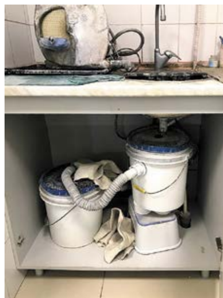
7 «Бахчисарайский фонтан» из двух гипсоотстойников ОГП 2.0 и еще одной табуретки
